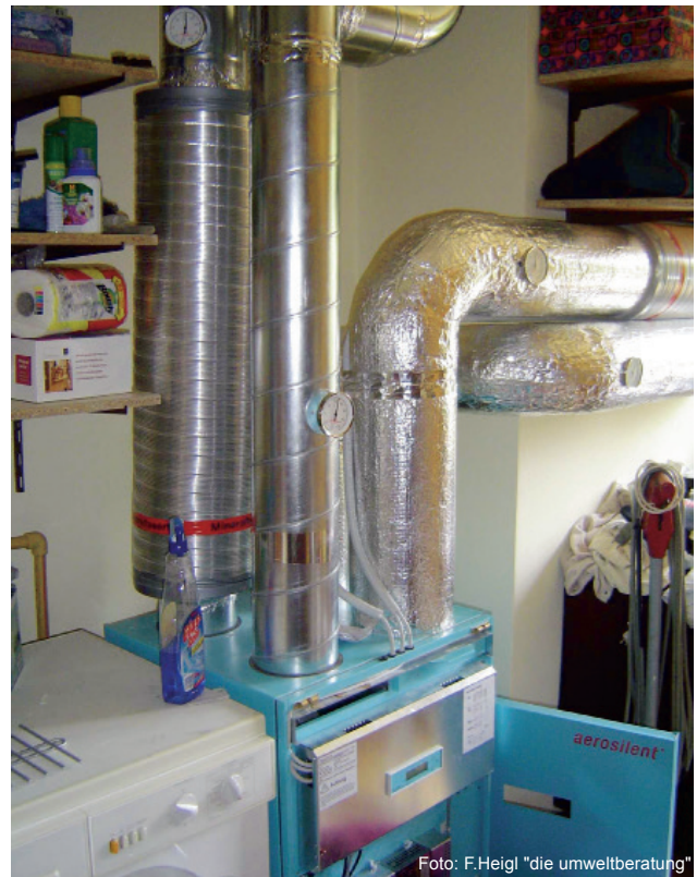
Eingebautes Lüftungsgerät einer Wohnraumlüftungsanlage mit Wärmerückgewinnung
