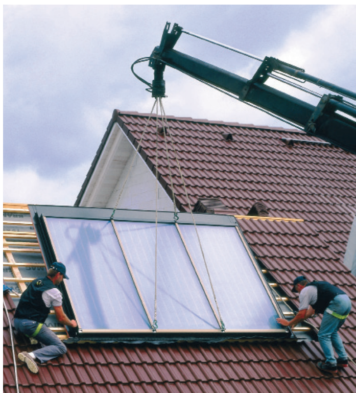
Foto: Austria Solar/Bramac Dachsysteme
