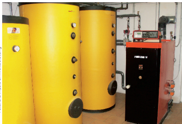
Holzvergaserkessel mit Pufferspeicher
