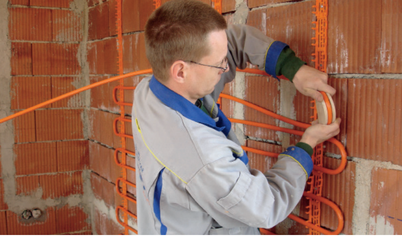
Verlegung der Heizfläche einer Wandheizung
