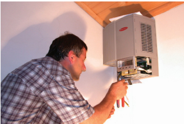
Montage Wechselrichter, Foto "die umweltberatung"
